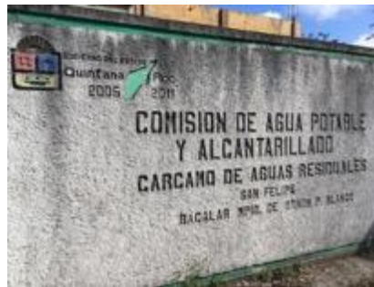
Figura 41. Entrada a cárcamo de bombeo de aguas residuales ubicado en Parque Bacalar (fotografía Arturo Balderas Torres).
