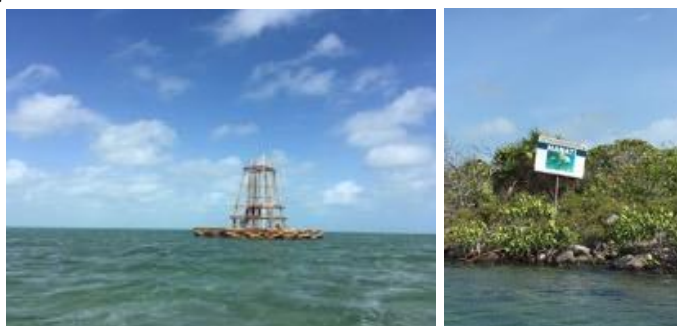
Figura 15. Torre de vigilancia en construcción y señalética en zona de Xcalak (fotografías Arturo Balderas Torres).
